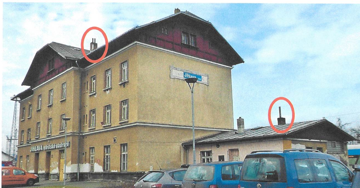
Foto č. 5 – Výpravní budova. Azbestocementové roury jako komínové nástavce.
