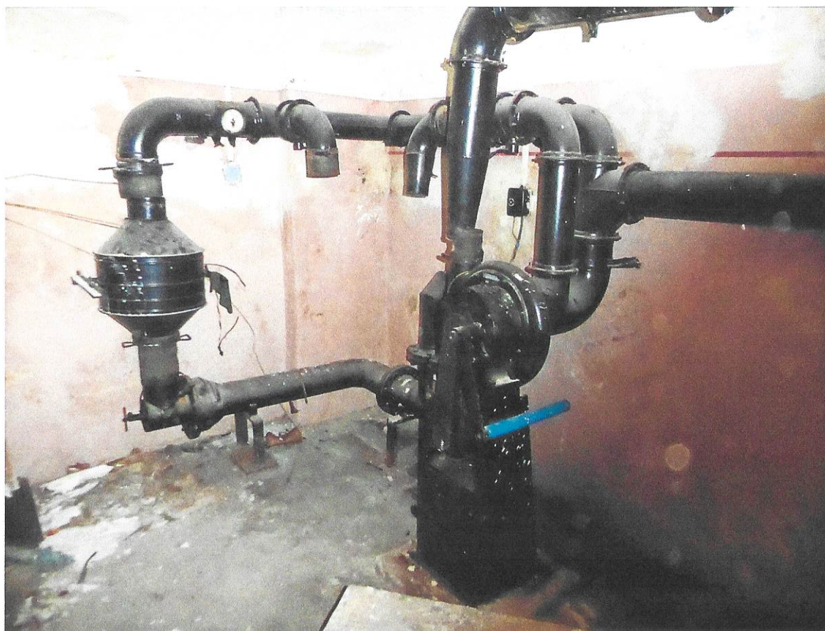
Foto č. 10 – Výpravní budova, suterén, prostory bývalého CO krytu. VZT technologie, jejíž příruby mohou být těsněny azbestovým těsněním viz Detail níže.
