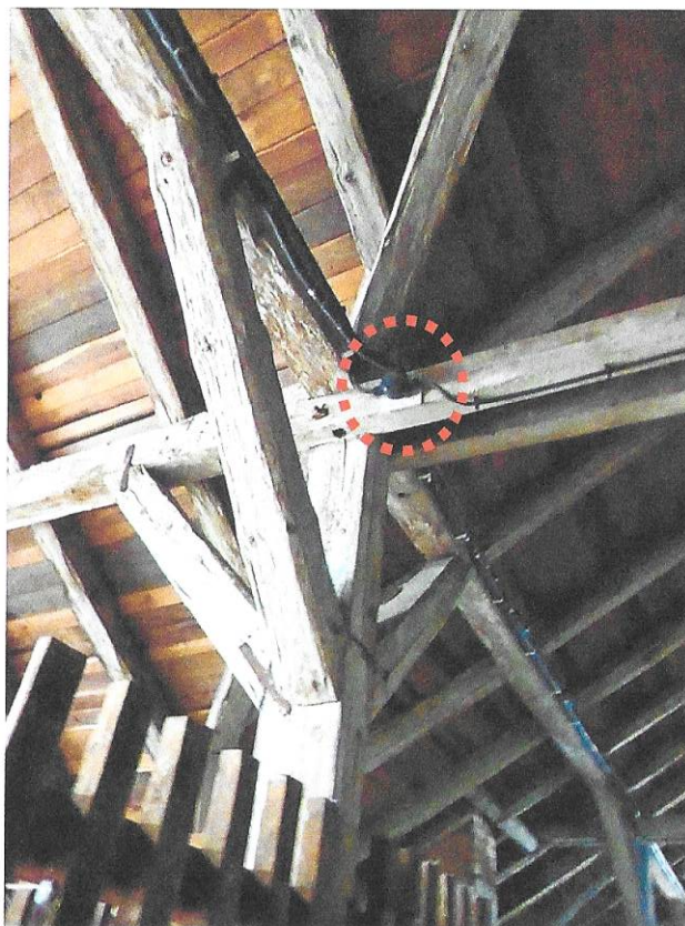
Foto č. 7 – Výpravní budova, půda. Azbestová podložka pod rozvodnou krabicí.
