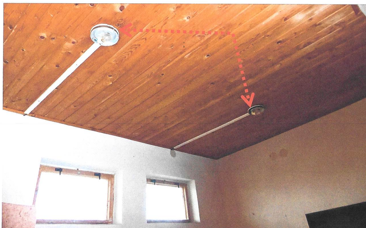
Foto č. 9 – Výpravní budova, bývalý kiosek. Azbestové podložky pod svítidly.
